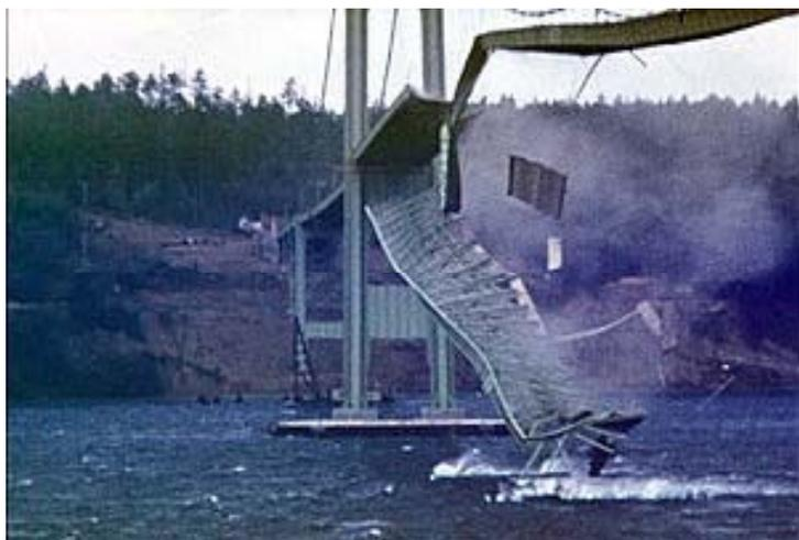
1940年11月7日、早朝より風による振動が続いていたが、風速が19m/sに達した途端、それまでの上下方向の振動から大きくねじれる揺れに変わった。このような揺れが1時間ほど続いた後、主径間の4分の1点で桁が座屈し、橋床が落下した。この直後に最終的な崩壊が始まり、結果として主径間では橋桁がケーブルからちぎれて崩落した。このため塔は側径間側に傾き、側径間は10メートルあまり下方にたわんだ。
