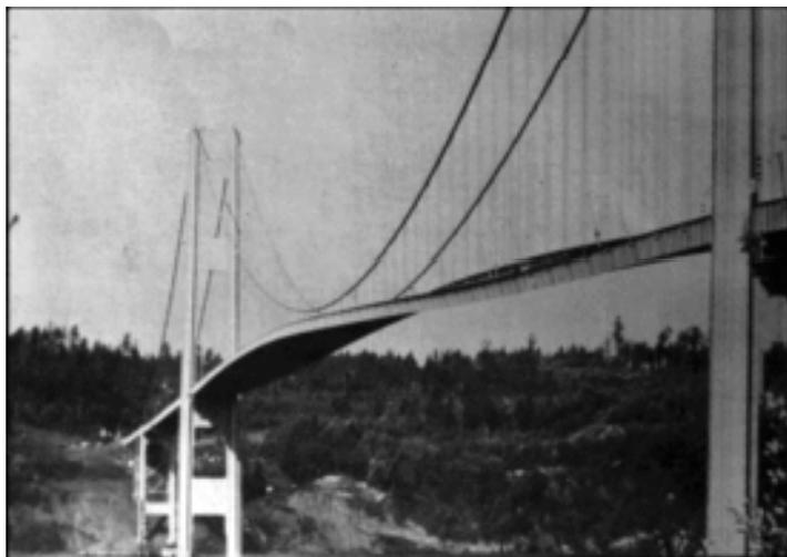
当初、余裕を取って幅広に設計されるはずであったが、コストの制約から自動車の対面通行に一応支障ない程度の、比較的狭い幅員で建設された。モイセイフはコストと構造合理化の両面を考慮し、橋本体について、橋桁の寸法をごく薄くした野心的な軽量設計を採用した。当時最新の架橋理論によれば、これでも必要な強度は確保でき、強風にも耐えられると判断されていたが、専門家の一部にはこれを不安視する声もあった。
